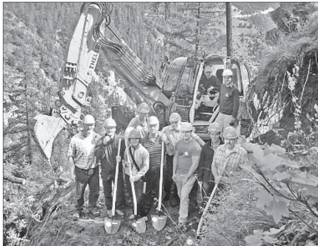
Gemeinderätin Lucia Näfen und Stadtgenieur Björn Wyss inmitten der ausführenden Unternehmer beim Spatenstich. Foto zvg
