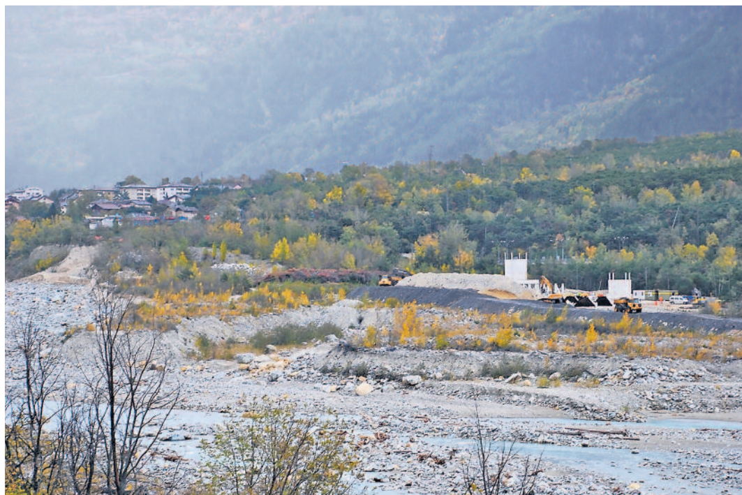
Kieswerk Susten. An der Mündung des Illgrabens entsteht eine neue, geschlossene Anlage. FOTO WB
